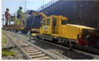
Manutenzione ordinaria e somma urgenza
